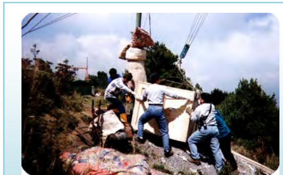
圖說：利用流籠吊運 TAOS 望遠鏡至鹿林天文台，在當時無路可及的情況下，大部份設備皆由人力搬運。@中研院天文所
