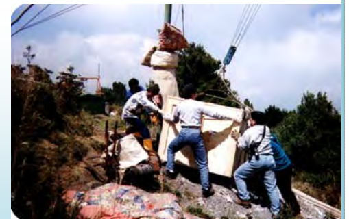
圖說：利用流籠吊運 TAOS 望遠鏡至鹿林天文台，在當時無路可及的情況下，大部份設備皆由人力搬運。@中研院天文所
