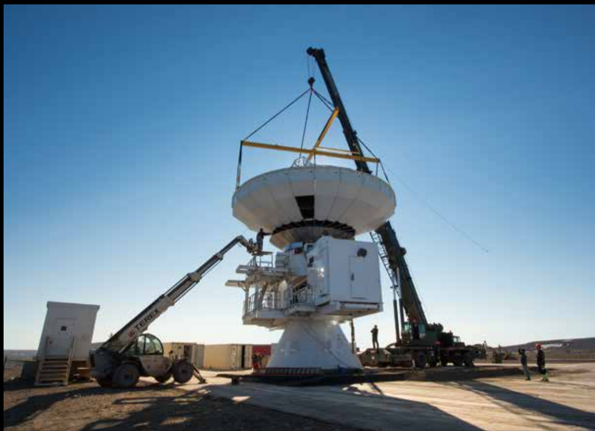
吊車正協助安裝碟面到主體上。© 中研院天文所
