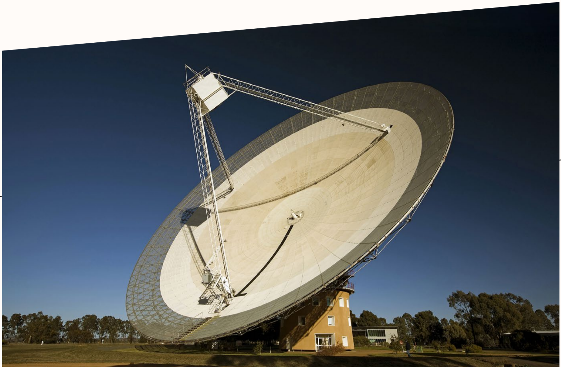
用來發現 FRB 的電波望遠鏡。一台單碟望遠鏡能夠一次觀測像月球一樣大的區域，位於澳洲的帕克斯望遠鏡被用來發現第一批 FRB，天線的直徑是 70 米。 ©David McClenaghan, CSIRO
