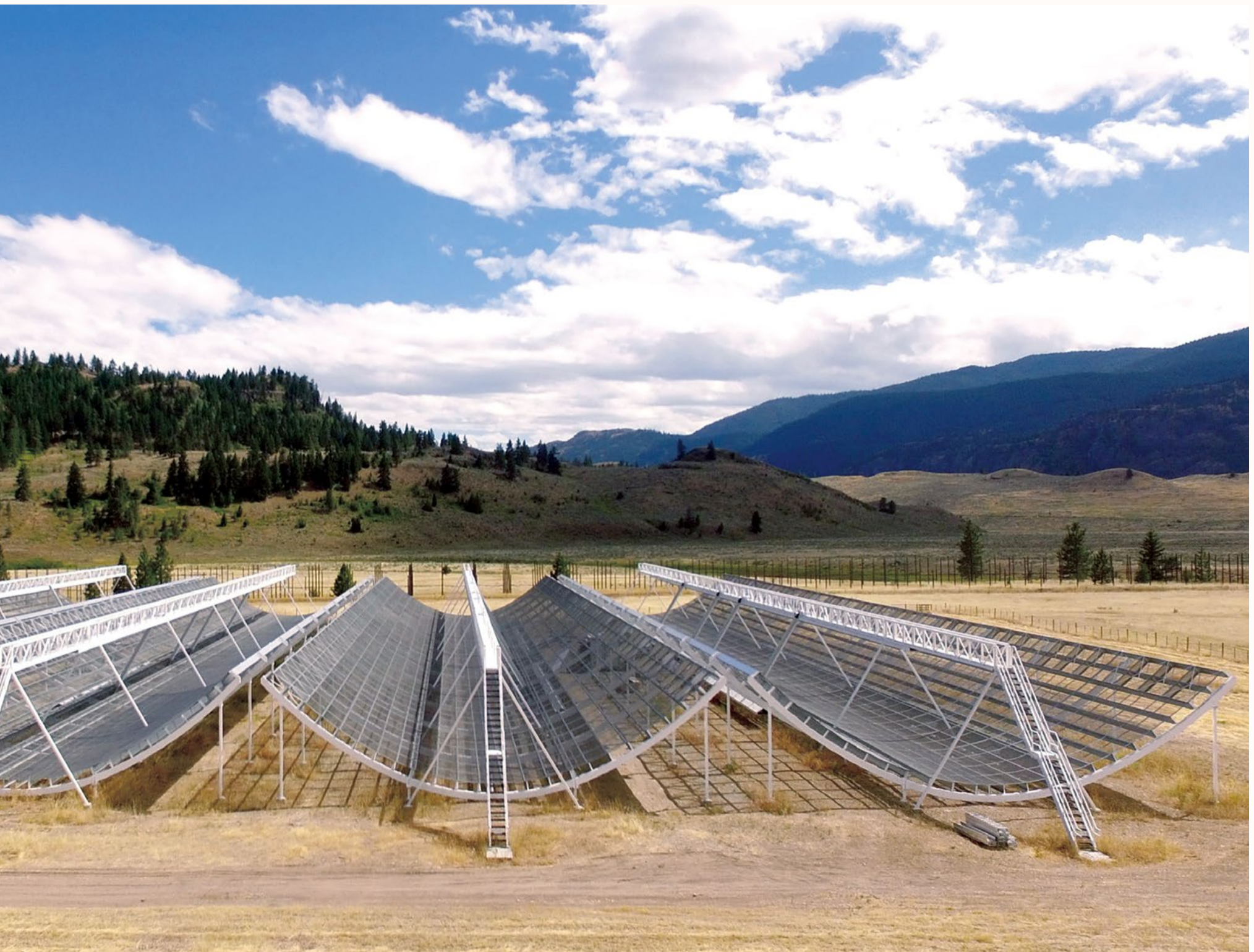
加拿大的 CHIME 望遠鏡是由四個 100 米長、20 米寬的半圓柱狀金屬網構成，搭載 1024 個電波接收器，能同時搜尋大範圍的天空。©CHIME
