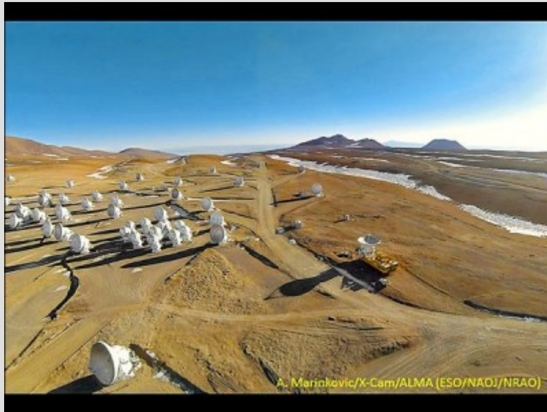
ALMA 天文望遠鏡在智利高山的分布情形，每座天線碟盤直徑達 12 公尺。（圖：李景輝博士提供）
